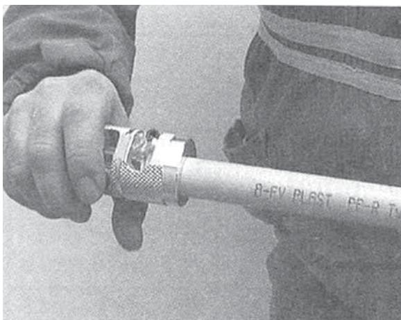
Kod cijevi STABI skinemo rezačem gornji sloj plastike i aluminija. Tako ćemo dobiti cijev glatke površine i dimenzije kakva treba za zavarivanje
